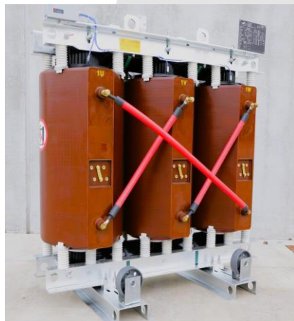
Transformateur sec de distribution standard 800 kVA - 20 kV
