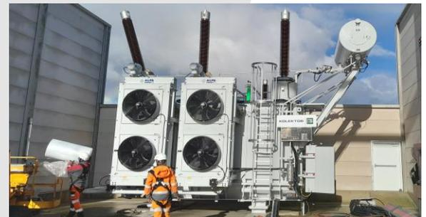
Transformateur de puissance de sous-station électrique 70 MVA – 225 kV, ENEDIS, FRANCE
