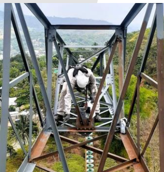
Application du revêtement GALVAGRID®
