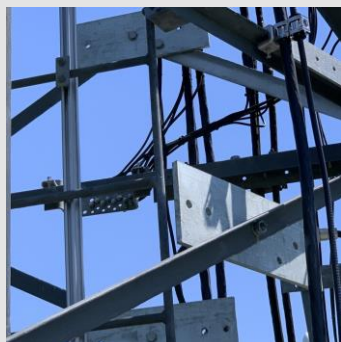
Protection galvanique des pylônes électriques
