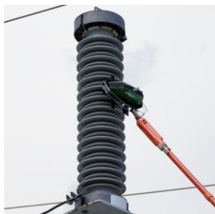
Testeur d'isolateur en sous-station
