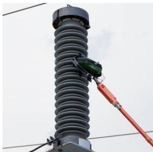
Testeur d'isolateur en sous-station
