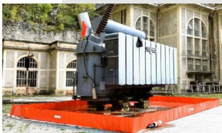
Bac de stockage souple à fortes contraintes mécaniques TRFLEX®-ECO+ équipé d'un filtre SPI® PETRO-PIPE
