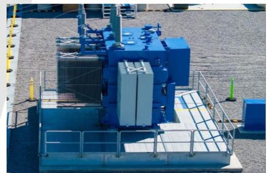
Bac de rétention TRT-LHD-MODULO 3 avec rambarde et escaliers d'accès pour transformateur en MIDEL 7131
