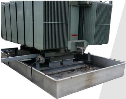
Transformateur de puissance à huile équipé d'un bac de rétention TRT®-W
