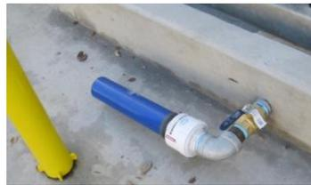
Filtre PETRO PIT 416 monté sur une fosse de rétention en béton
