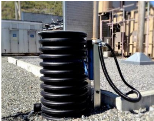
Petro Barrier Pumped PTB 24 collegato a pompe per pozzetti o a soluzioni di disidratazione con livello di rilevamento dell'olio e dell'acqua per garantire < 5 ppm GRIDO NAZIONALE, RTE o EON
