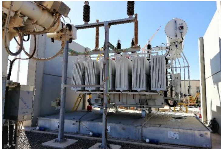
TRT-MODULO 3 Serbatoio dotato di copertura antincendio EXTICOV LHD e cartuccia di filtrazione PETRO PIT SPI - NATURGY, IBERDROLA, SCHNEIDER, SNCF...
