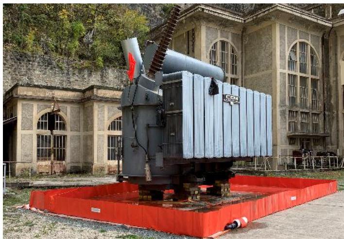
Serbatoio flessibile TRFLEX-ECO+ per lo stoccaggio temporaneo all'aperto, dotato di 2 filtri SPI PETRO-PIPE PI616-M2 - EDF
