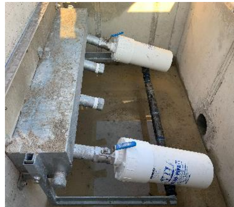
PETROPIPE PI-616-M2 da solo o montato su SANERGRID SKID 1x4 PETRO PIPE per drenare per gravitazione il bacino di contenimento dell'olio del trasformatore o la fossa di cemento senza rischio di contaminazione dell'acqua - Gruppo EDF, CONEDISON o EXELON
