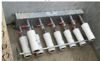
PETRO PIPE PI-616-M2 in SKID per il drenaggio a gravità di pozzi sfalsati, circa 200 L/min.
