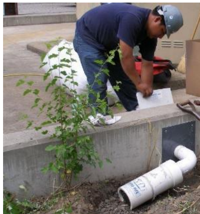
PETROPIPE PI-616-M2 da solo o montato su SANERGRID SKID 1x4 PETRO PIPE per drenare per gravitazione il bacino di contenimento dell'olio del trasformatore o la fossa di cemento senza rischio di contaminazione dell'acqua - Gruppo EDF, CONEDISON o EXELON
