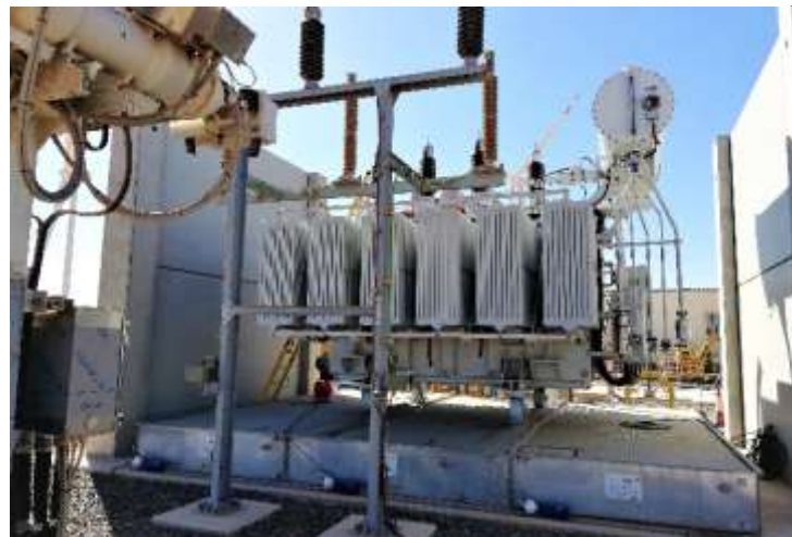
Bac TRT-MODULO 3 équipé d'une couverture coupe-feu EXTICOV LHD avec cartouche de filtration PETRO PIT SPI® - DALKIA
