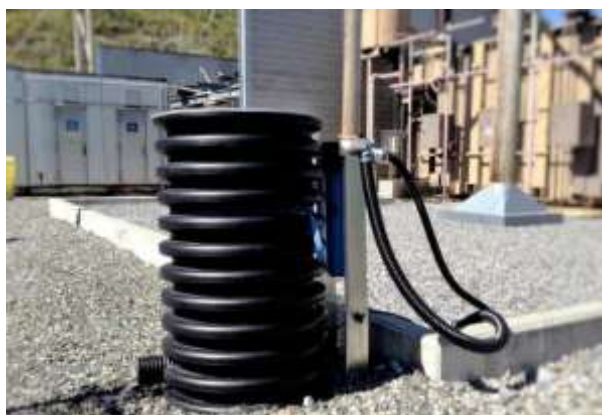
Petro Barrier Pompé PTB 24 en dehors de la rétention, connecté à une pompe pour filtrer le trop-plein de la fosse déportée - NATIONAL GRID
