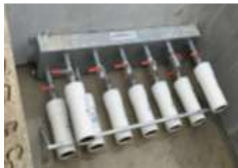
PETRO PIPE PI-616-M2 pour drainage gravitaire de fosse déportée, approx. 200 L/min
