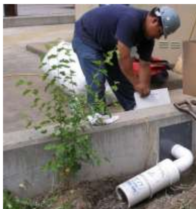
Le PETROPIPE PI-616-M2, utilisé seul ou monté sur un châssis SANERGRID SKID 1x4 PETRO PIPE, permet de vidanger par gravité le bassin de rétention d'huile de transformateur ou la fosse en béton sans risque de contamination de l'eau - EDF, CONEDISON ou le groupe EXELON
