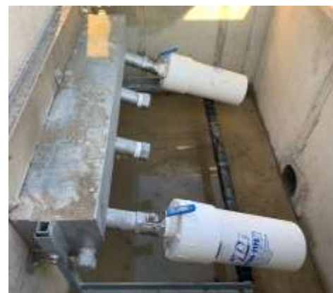
Le PETROPIPE PI-616-M2, utilisé seul ou monté sur un châssis SANERGRID SKID 1x4 PETRO PIPE, permet de vidanger par gravité le bassin de rétention d'huile de transformateur ou la fosse en béton sans risque de contamination de l'eau - EDF, CONEDISON ou le groupe EXELON
