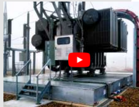
Transformateur de puissance sur bac de rétention modulaire SANERGRID TRT-MODULO 4 équipé de cartouches de filtration SPI PIT416
