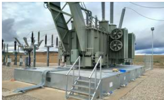
Bac de rétention modulaire anti feu ERT-MODULO 5 avec escalier d'accès et cartouches de filtration PETRO PIT - REPSOL
