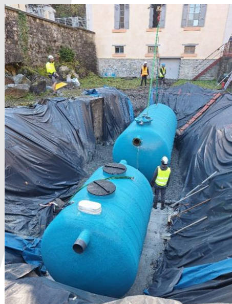
Exemple d'une DEPOSIT®-MV de 20 mètres cubes de rétention, équipée en sortie d'un séparateur hydrocarbures DEPOSIT®-SEPTO .
