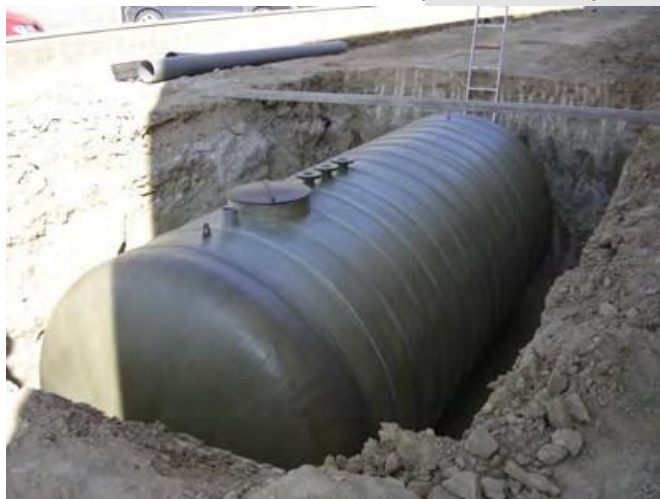
Exemple de DEPOSIT®-DW ou Deluge Water, asservies à la détection incendie, conçues pour recevoir de gros volumes d'eau, polluée aux hydrocarbures, aux produits chimiques, etc.
