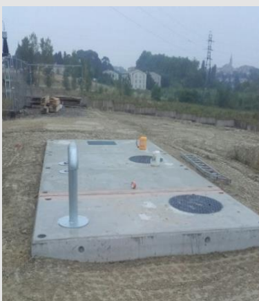
Exemple de fosses déportées béton préfabriquées ou maçonnées sur place.
