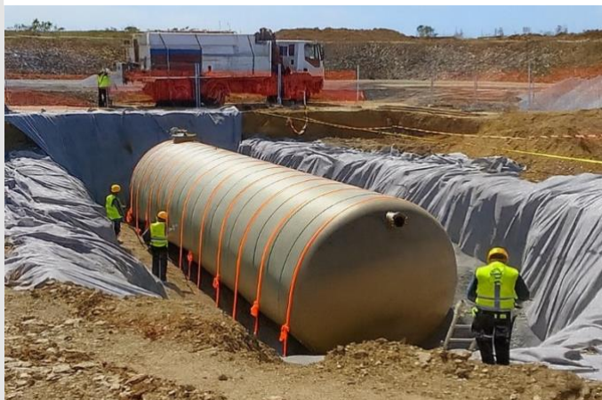
Exemple de mise en œuvre d'une fosse déportée DEPOSIT-MV de 60 mètres cubes de rétention utile.
