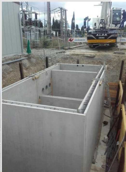
Exemple de fosses déportées béton préfabriquées ou maçonnées sur place.
