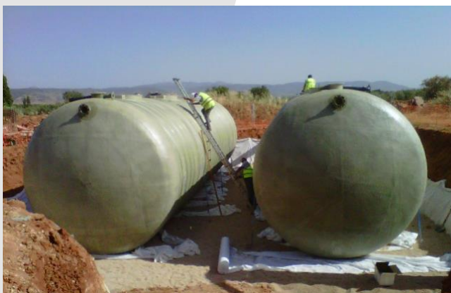
Exemple de deux DEPOSIT®-MV 100 , chacune d'une capacité de rétention de 100 mètres cubes, mises en parallèle pour assurer une capacité totale de 200 mètres cubes.
