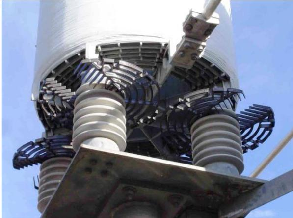
La spécificité des disques de protection MIDSUN E/BARRIER réside dans leur conception monobloc en polycarbonate, permettant une installation rapide sans colle ni chauffe. Ces barrières se montent facilement en glissant entre les jupes d'un isolateur et s'adaptent à différents diamètres de noyaux, ce qui les rend compatibles avec de nombreux équipements de poste tels que les isolateurs, sectionneurs, parafoudres et supports de jeux de barres.
