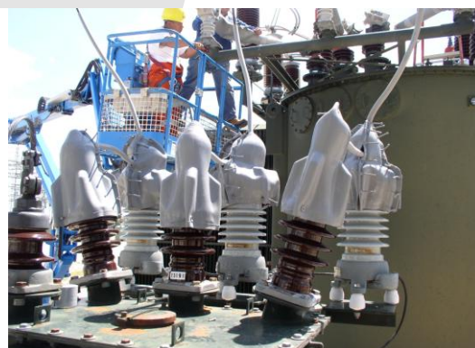
Installation des protections MIDSUN E/COVER et E/FOURREAU sur isolateurs et connexions HTA
