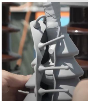
Mise en place E/COVER en complément de E/TAPE avec ses clips de fixation
