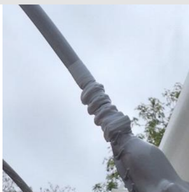
Continuité d'isolation assurée par l'usage simultané d'E/COVER, d'E/TAPE et d'E/FOURREAU
