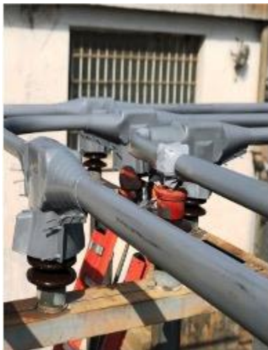
Gaine E/FOURREAU AVIFAUNE pour isolation des câbles et jeux de barres
