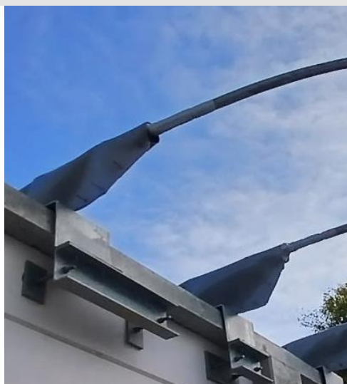
Installation des protections MIDSUN E/PLAQUE et E/FOURREAU sur lignes aériennes
