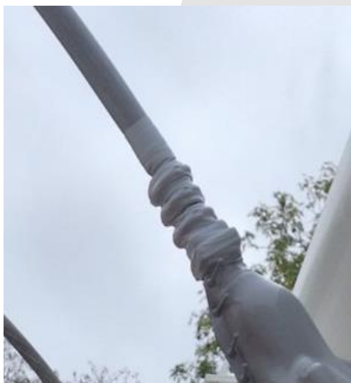
Continuité d'isolation assurée par l'usage simultané d'E/COVER, d'E/TAPE et d'E/FOURREAU
