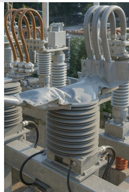
E/PLAQUE : isolation modulable suivant la géométrie de l'isolateur et de la connexion
