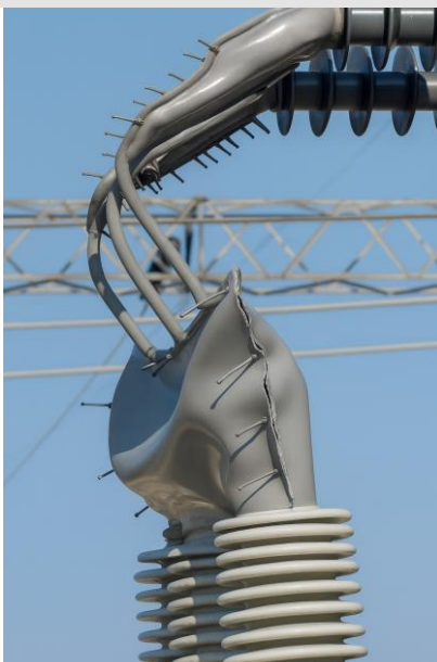
Isolation flexible de l'E/PLAQUE adaptée au contour des faisceaux de câbles
