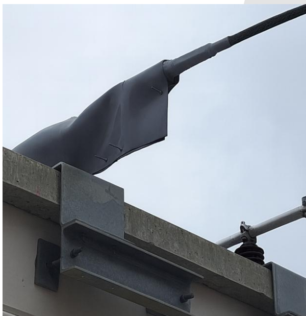
Mise en place E/COVER en complément de E/TAPE avec ses clips de fixation
